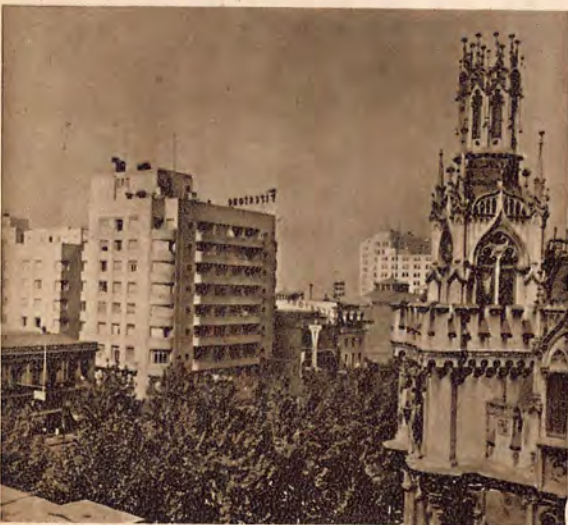
Alameda Bernardo O'Higgins y Estado
